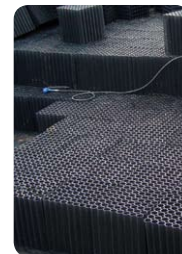
Przykładowa instalacja obejmująca kilka warstw modułów AquaBlok®
